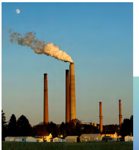
美国电力公司位于俄亥俄州康斯维尔的燃煤电厂 Michael S. Williamson/The Washington Post
